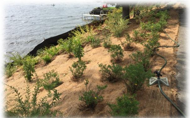
En remplacement du paillis naturel, nous avons eu recours à une membrane de paillis de noix de coco compte tenu de la pente du terrain. Cette membrane permet de recouvrir la végétation herbacée en place tout en permettant aux plantes d'accroître. Avec le temps, les arbustes grandiront et retiendront le sol en place.
