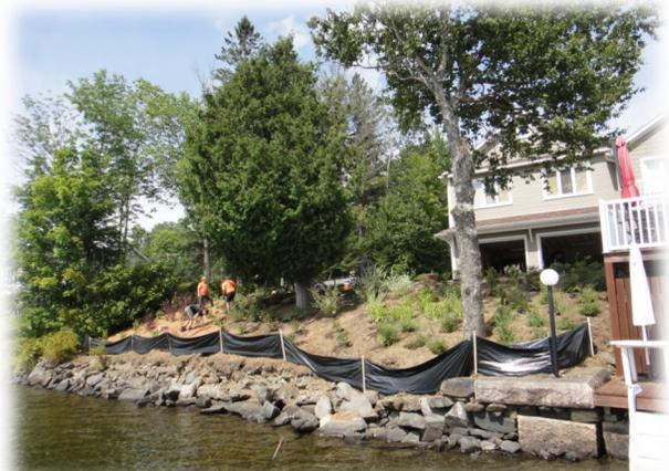
Pour ce projet, la barrière de sédiments est installée, car la pente du terrain est abrupte. Cette mesure permet d'éviter l'apport de matériaux au lac. La barrière peut être retirée après les travaux.
